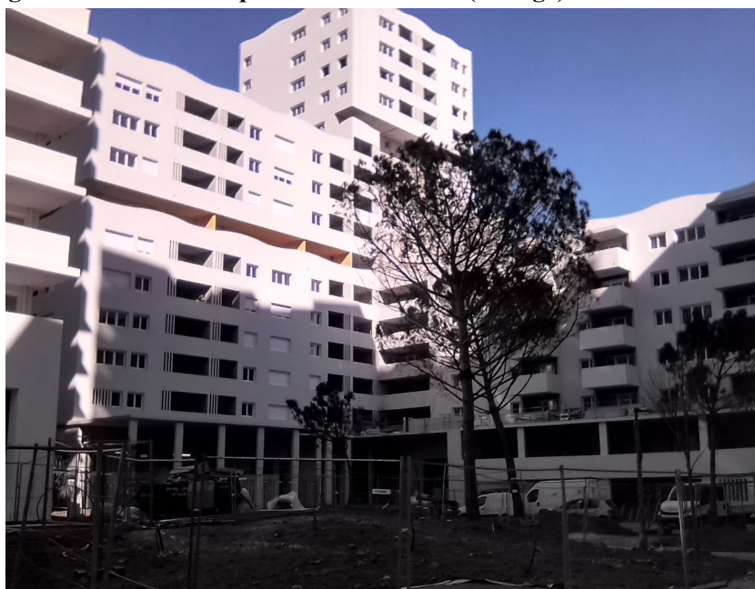
Figure 2. Le nouveau quartier Smartseille (Eiffage)
